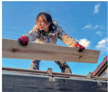
屋根を修繕するTADA。近隣の家のリフォームなどのオーダーを受け付けている
