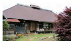
茅葺き屋根をガルバリウム鋼板でカバーし、各所補強した
